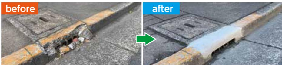
歩道にある排水溝が激しく破損しており区に対応を依頼。安全な形に補修してもらいました。
